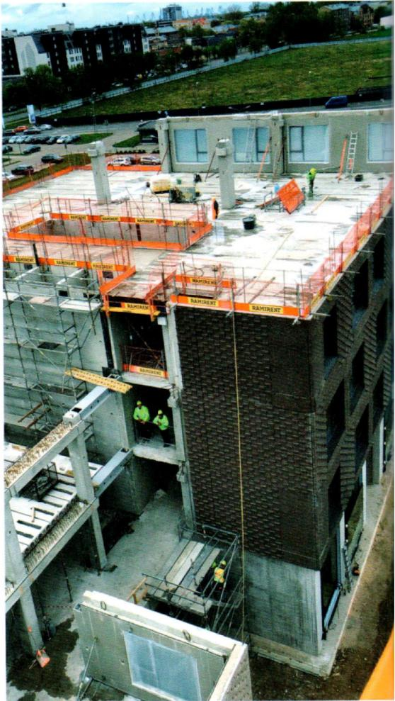
tipa sienu paneljiem ar zāģētu 20 mm un 50 mm biezū māla kieģeļu apdarī. Fasāžu apdarē izmantoti trīs dažādu tonu kieģeļi – pirmsās stāvs vizuāli apvienots ar melnu kieģeļu apdarī, savukārt korpusu 2.–12. stāva apdarē izmantoti gaiši un tumši pelēki kieģeļi. Fasādes paneļos integrētas logu noēnošanas žalūzijas. Noēnojuma risinājums ar izvelkamu noēnojuma sistēmu izmantots arī pirmā stāva stiklotajām vitrīnām.
