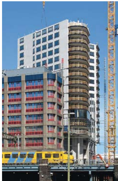
Hāgas saliekamā dzelzsbetona augstceltne būvniecības laikā. Attēli no wikipedia.org.
