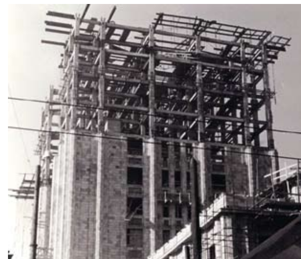
Saliekamā dzelzsbetona konstrukciju izmantošana LZA ēkas jeb Kolhoznieku nama būvniecībā, 20. gadsimta 50. gadi. Attēls no forum.myriga.info.
