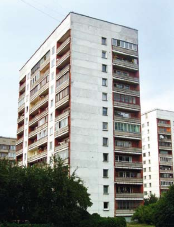
Šis ēkas neatbilst Eirokodeksu konstruktīvajām integritātes prasībām.
