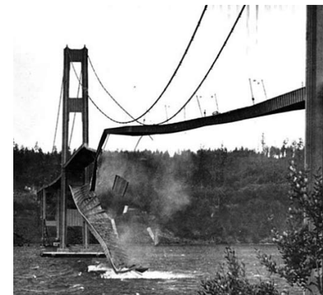
Takomas tilts 1940. gadā sabruka aerodinamiska flatera dēļ.
