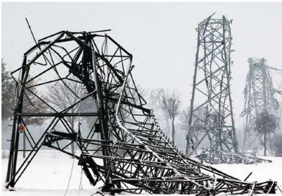
Domino tipa progresējošo sabrukumu elektropārvades līnijā Vācijā 2005. gadā izraisīja apledojuma radīta slodze.
