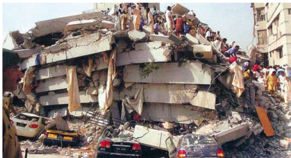
Pankūktipa sabrukums desmitstāvu ēkā pēc zemestrīces Islamabadā 2005. gadā.
